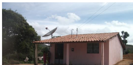
Foto 03: Nova residência: casa de alvenaria. Fonte: Souza, 2013.
